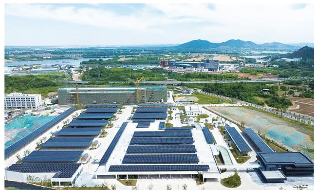
日前,在湖州安吉鞍山村,全国最大的光伏储能充换电一体站,绿色低碳综合供能链项目一期首站——鞍山站,投入试运营。该站占地106亩,共配设光伏4.2兆瓦、储能容量8388千瓦时,包含30个快充桩、400个可调桩以及2个换电站,分维修区、服务中心、停放区等区域,可同时满足400辆工程车停放充电需求。
