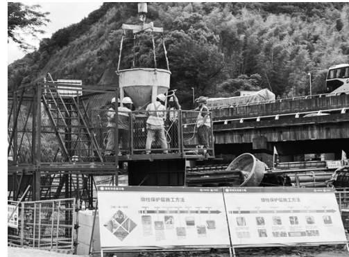
墩柱施工现场。毛琼莺/供图
