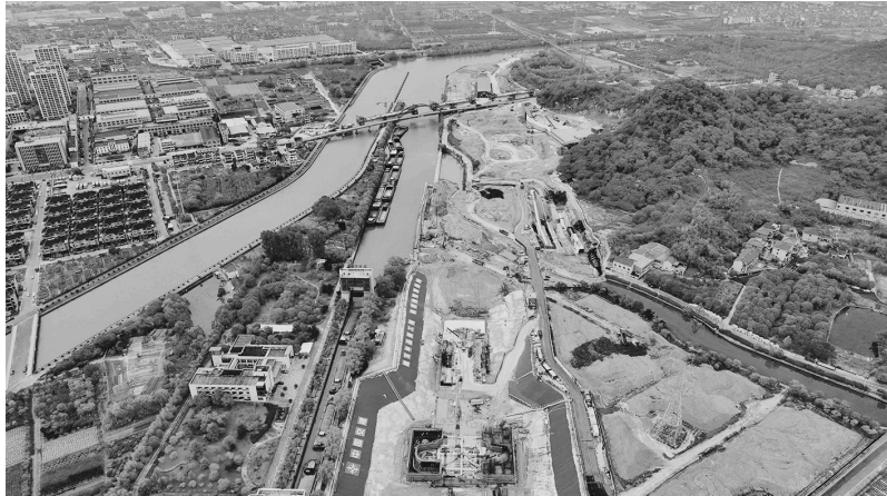
建设现场。韩潇/供图
