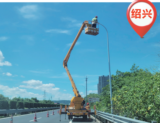
近日,浙江交通集团高速公路绍兴管理中心组织人员对辖区沿线特殊路段的照明设施进行维护保养。 □李洪宇
