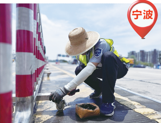
日前,浙江交通集团宁波收费站组织安装了新的隔离护栏,以便为过往车辆提供了更加清晰、安全的指引。图为水电工对隔离护栏进行固定。 □胡腾腾
