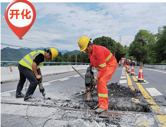
7月13日,开化县公路港航与运输管理中心组织养护人员前往205国道对大桥伸缩缝进行修复。 □徐曙光 楼雄军
