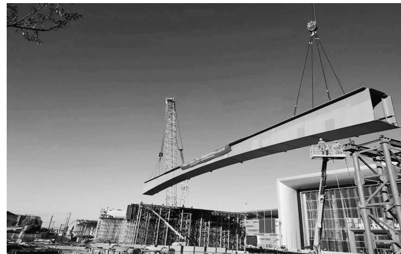
钢混组合梁架设现场。韩潇/供图
