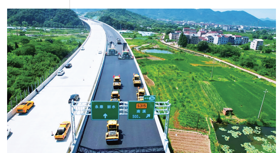
西坞大桥桥面沥青摊铺现场。韦凯锋/供图
