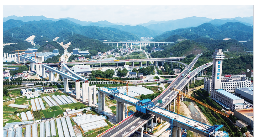
金建铁路建设现场。申硕洋/供图
