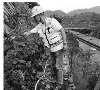
“拉网式”隐患排查到边到底。利用台风过后的晴朗天气，该中心着重对“三高”结构物，跨越河床较大、水流流速较大的桥梁进行结构检查，特别关注首次迎战台风的杭甬复线路段桥梁。此外，加密对桥梁、边坡和隧道的巡查频次，及时解决因短时间强降雨、树叶堆积造成的排水系统堵塞问题。而针对杭甬高速K287
