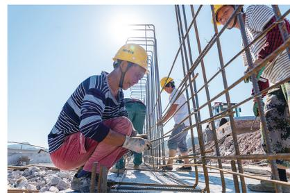
在浙江交通集团衢丽铁路东西岩站,工人正开展路基挡墙施工。 □通讯员 洪奇/摄影报道
