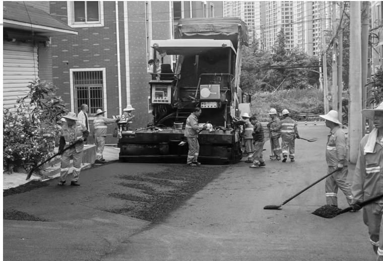
施工现场。徐瑶/供图
