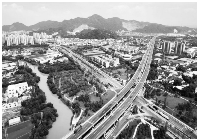
路桥加快交通基础设施建设(图为院路线与G104交叉口) 路桥交通/供图
