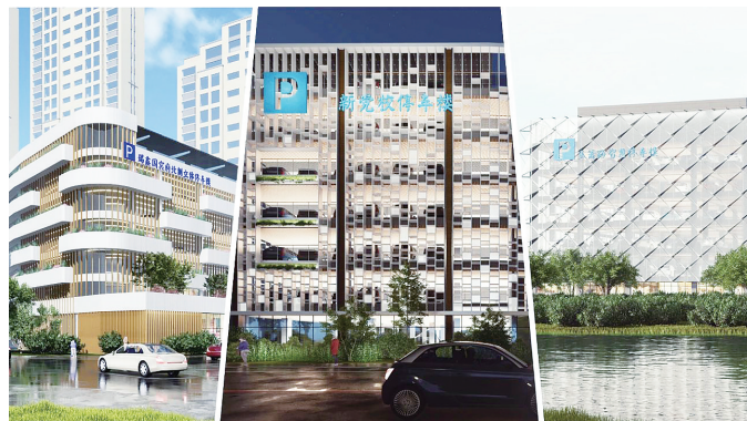
▲日前，乐清三个坡道式停车楼全面完工，验收投用后可增加910个车位（充电桩停车位135个），将有效缓解周边区域的停车压力，助力道路治堵。
