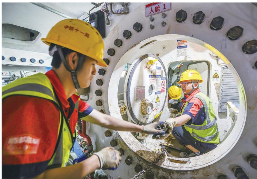
10月2日,施工团队在地下深处为“定海号”盾构机更换刀具。姚峰/摄
