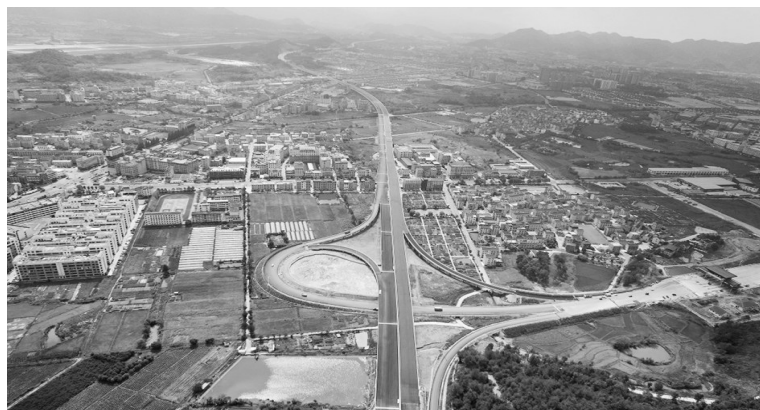
义东高速建设现场。韦凯锋/供图
