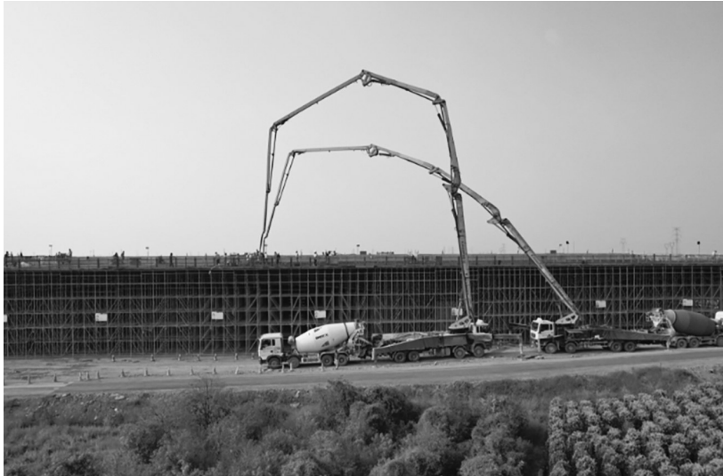
雅畈大桥施工现场。黄小羽/供图
