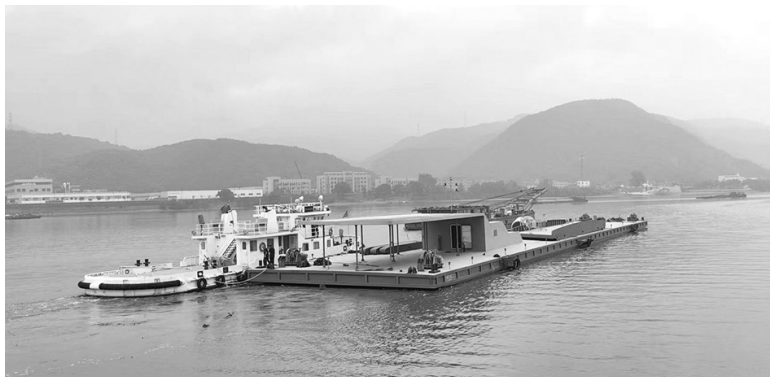
钢趸船牵引现场
