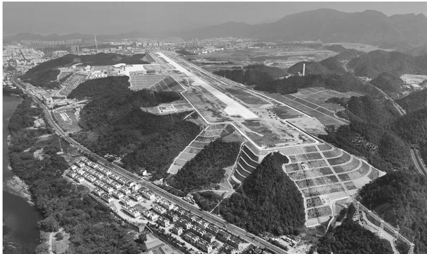
丽水机场建设现场
