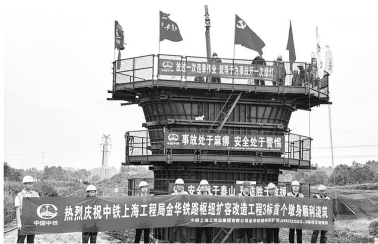
近日,金华铁路枢纽扩容3标项目白沙溪左线特大桥首个墩身完成混凝土浇筑,标志着项目将由桩基基础施工转入承台墩身施工。
