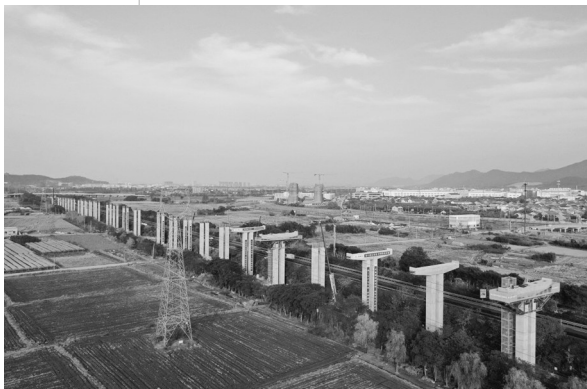
甬台温改扩建宁波南段1标鄞奉高架桥建设现场。王春艳/摄
