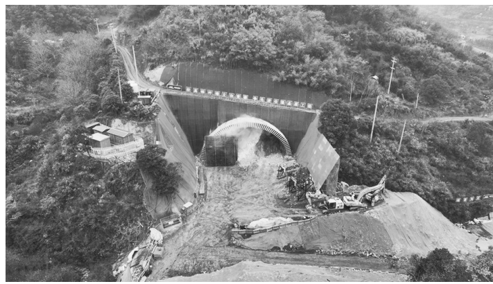
白峰岭2号隧道施工现场。杨童舒/供图
