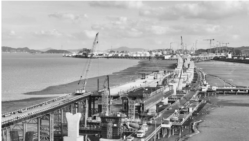
海域高架桥施工现场。陈芊/供图
