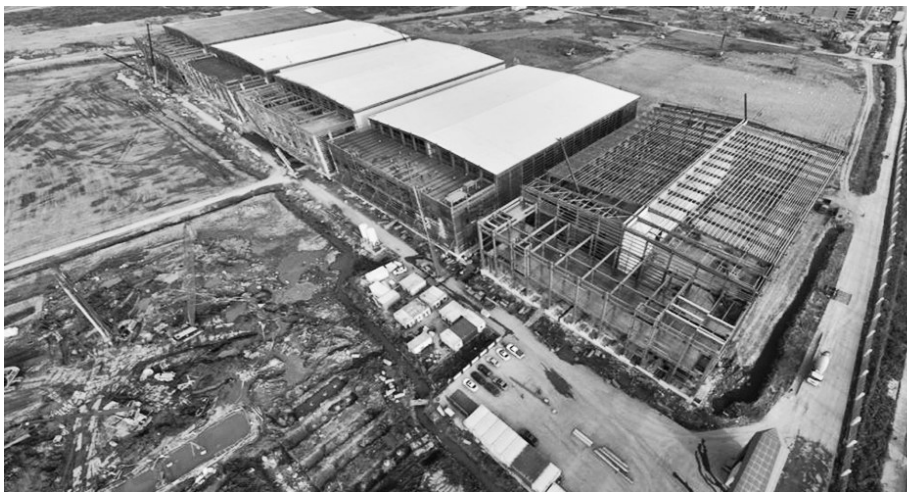
裕程国际物流园建设现场。受访单位/供图
