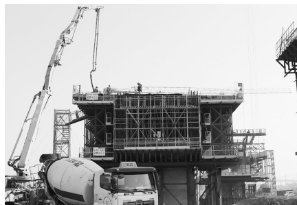
浇筑现场。张志强/供图
