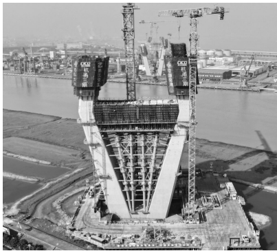
甬江特大桥建设现场。邵威/供图
