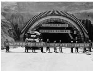
隧道施工现场。毛琼莺/供图
