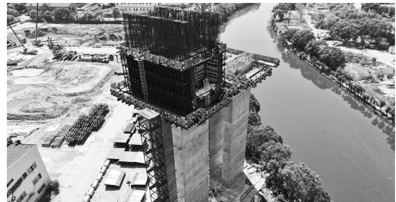
浇筑现场。钱杨/供图
