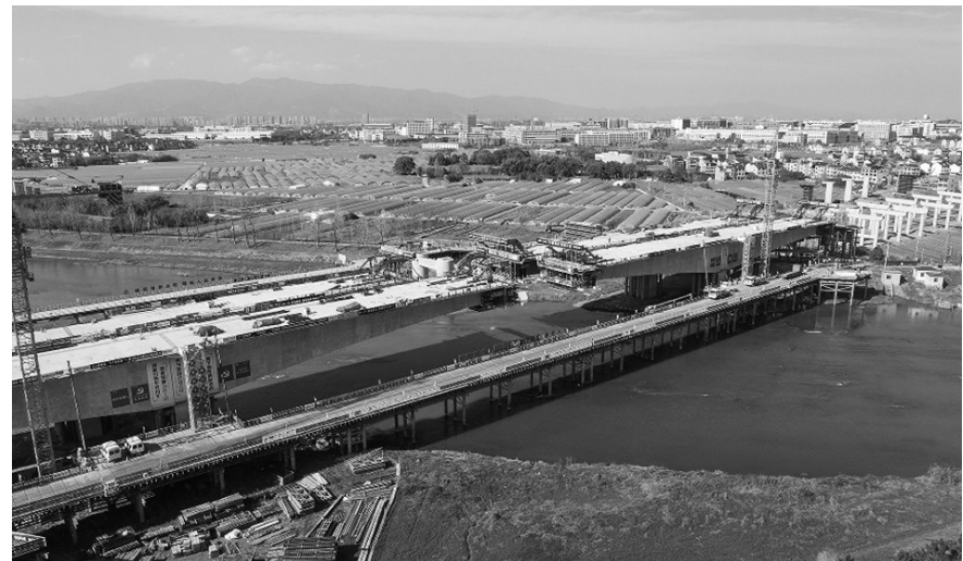
武义江特大桥挂篮施工现场。严恩/供图
