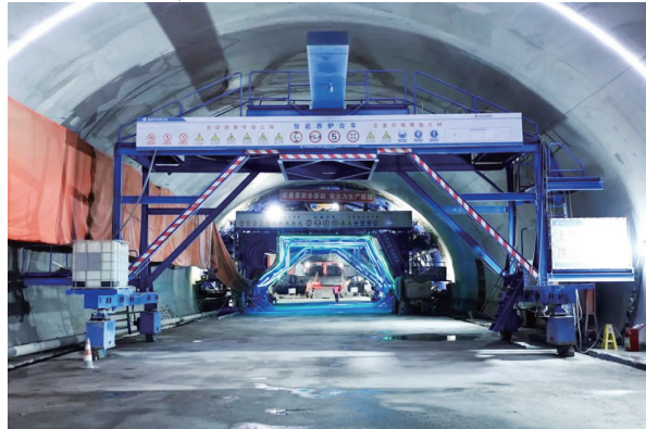
观音山隧道施工现场。孟丽萍/供图
