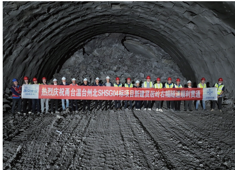
隧道贯通现场。孙嘉炜/供图
