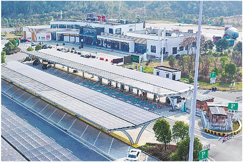
零碳改造后的次坞高速服务区,在充电站屋顶铺设光伏板,房屋边建设小型风力发电机,实现绿电自发自用。刘广扩/摄
