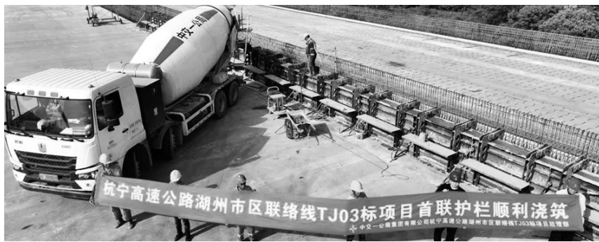
首联桥面系护栏顺利完成浇筑。 孟丽萍/供图
