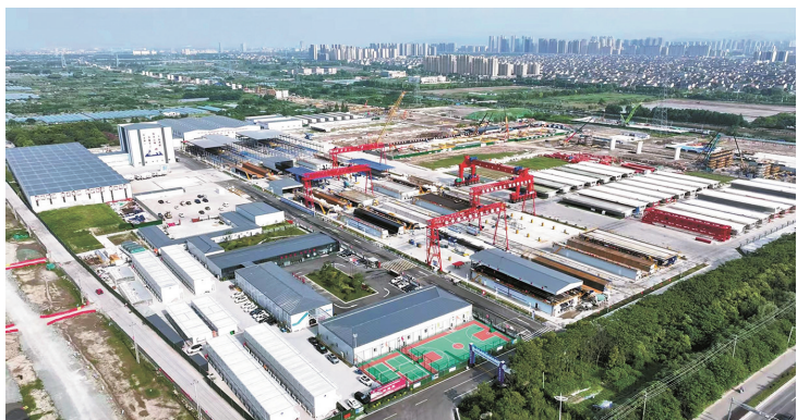
慈溪制梁场与远处的通苏嘉甬高铁施工现场。王嘉彬/摄
