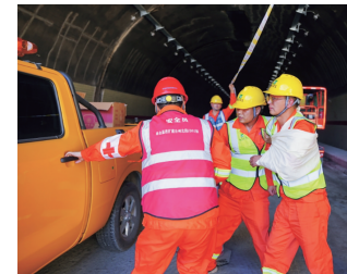
隧道交叉施工综合应急演练现场。黄晓宇/供图
