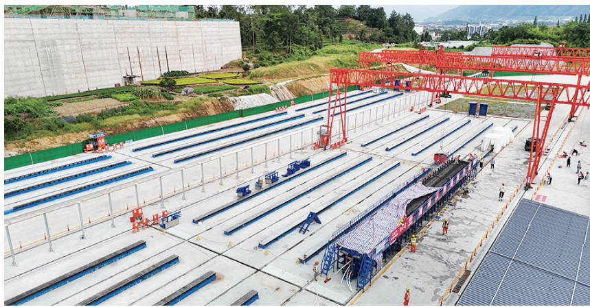
预制T梁浇筑现场。 潘皓钺/供图
