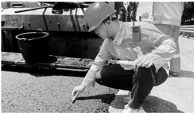
施工现场。方丽/供图
