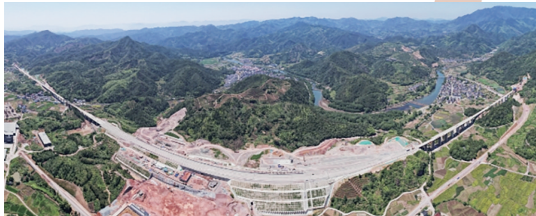
衢丽铁路东西岩站建设现场。洪奇/供图
