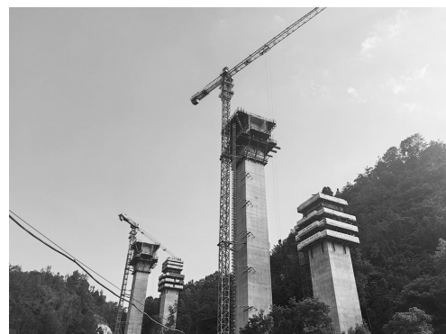
施工现场。刘米连/供图
