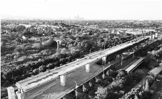
在高空,智能模板移动系统如同在“隐形传送带”上运行,庞大模板无需吊车“搬运”吊装,就能自动平稳“行走”至下一个工位。仅单榀现浇梁就省去68次吊装,累计减少吊装达5000余次。模板拆装时间更是从2天骤降至2小时。
