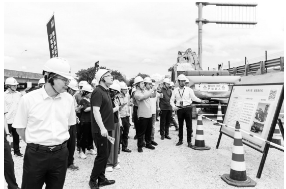
新老路基 拼接施工现场 观摩会。 曹勇/供图
