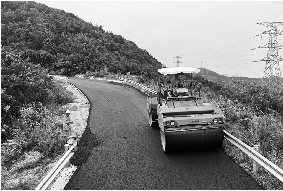
施工现场。龚兆华/供图
