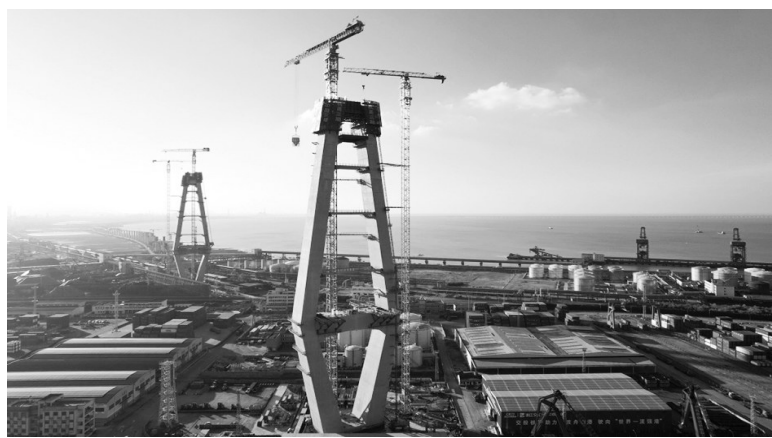
浇筑现场。毛佳莹/供图
