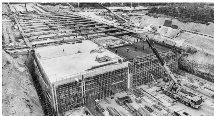
建设现场。陈业/摄
