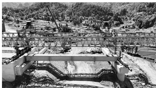
建设现场。叶轩绮/供图
