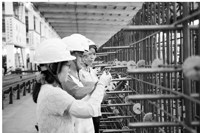
学员们 现场施工体 验。 朱彤/供图
