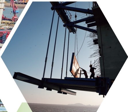
▲金台铁路头门港支线二期项目挂篮施工现场。金宸弘/摄 ▲瑞苍高速公路建设现场。李昭奕/供图
