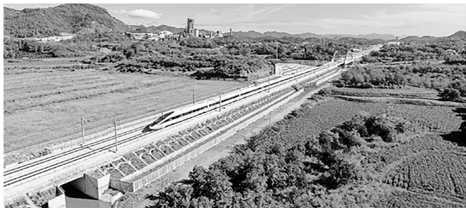
综合检测列车在杭衢高铁线路上飞驰。严锐/摄
