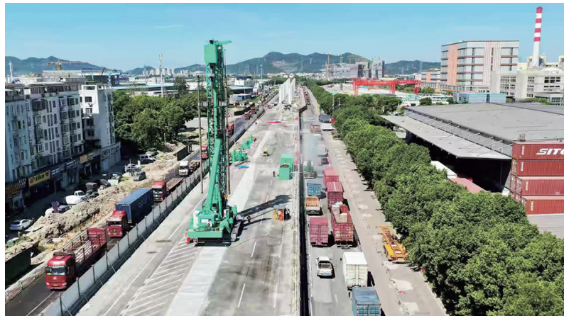
施工现场。张振宇/供图
