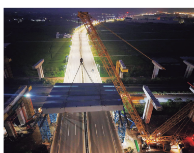
架梁施工现场。赵祥师/摄
