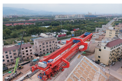
施工现场。中铁四局/供图
