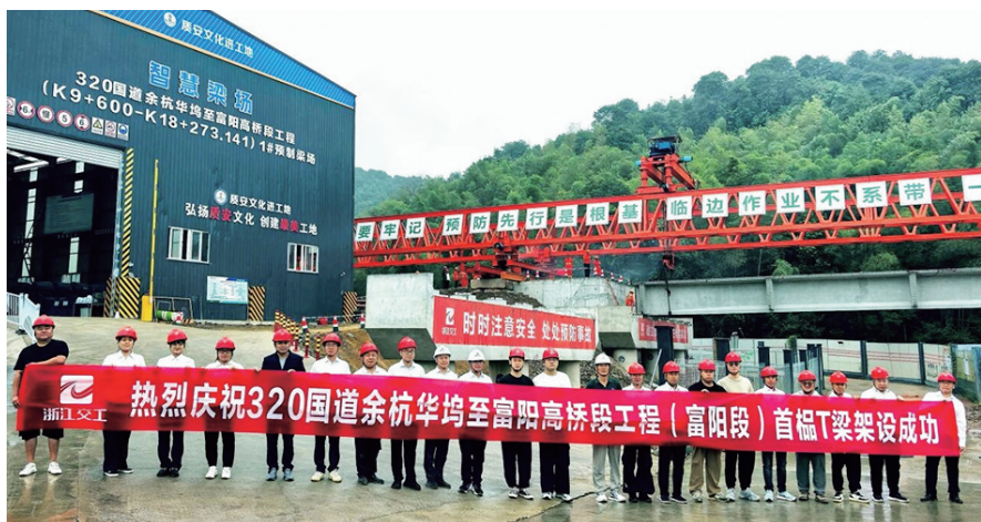
建设现场。吴昊/供图
