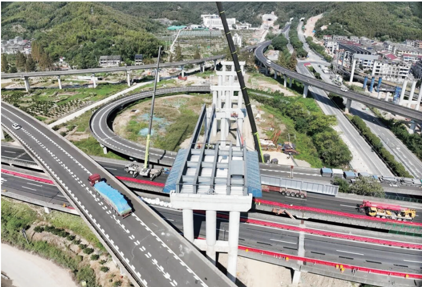
钢板叠合梁吊装现场。毛琼莺/供图
