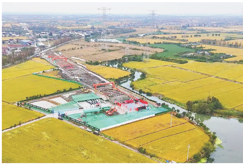
项目建设现场。嘉兴市铁投集团市域铁路公司/供图
