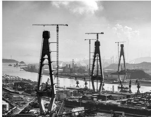
近日,甬江特大桥P58索塔封顶。据介绍,甬江特大桥全长1730米,主跨570+540米,是世界上最大跨径的三塔不对称斜拉桥,主塔身最高223米(P59号),当天封顶的是P58号索塔(高217米)第39节段施工,单节混凝土浇筑量为140立方米,钢筋用量为28吨。
