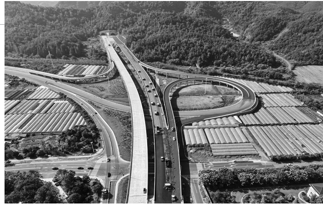
351国道二期浦江联盟至兰溪界段工程建设现场。
