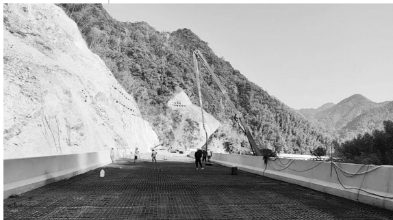
施工现场。吴玮霆/供图
