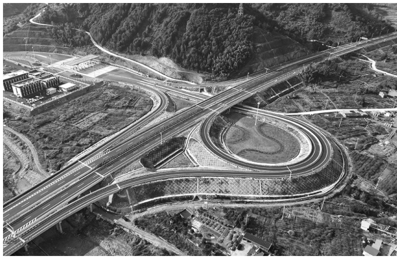
项目俯瞰图。陈能/供图
