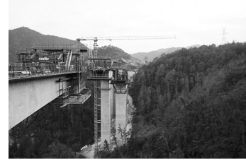
玉泉溪大桥建设现场。刘米连/供图
