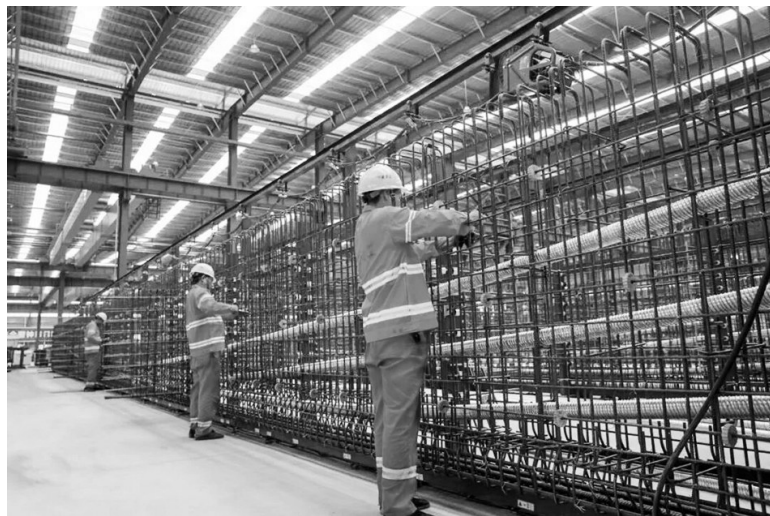
工人捆扎钢筋。毛琼莺/供图
