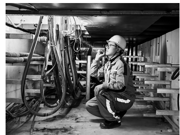
检修现场。郑婉倩/供图
