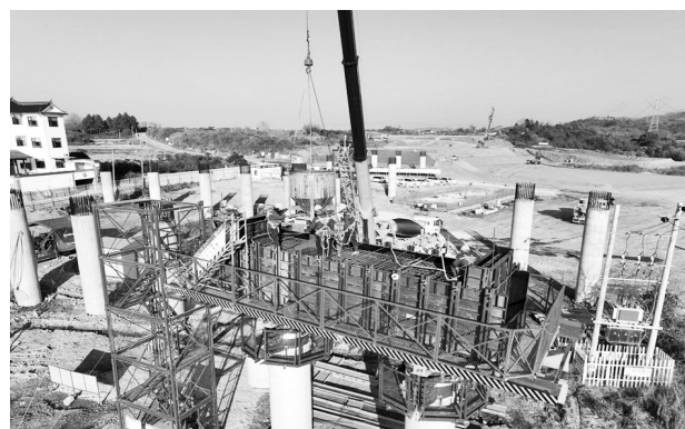
后溪互通建设现场。孙汝兰/供图
