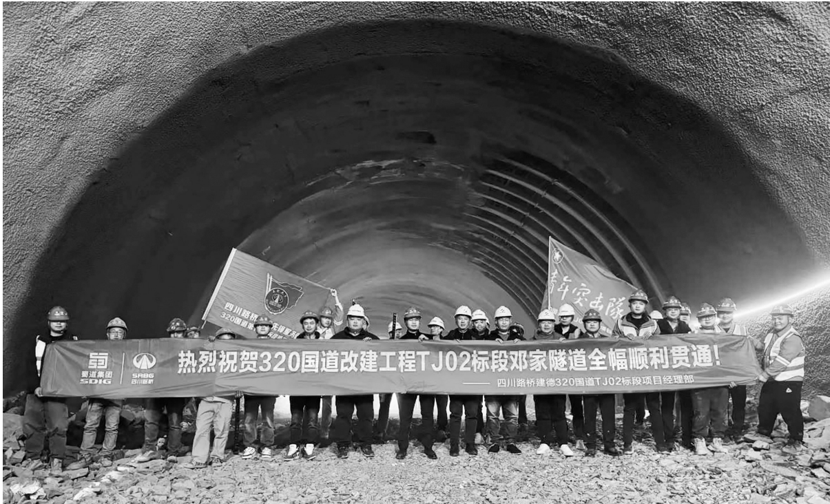
隧道贯通现场。邵茂华/供图
