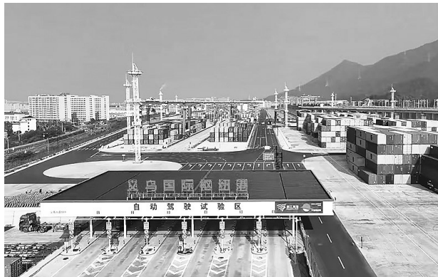
义乌国际枢纽港卡口及堆场。汪孜/供图
