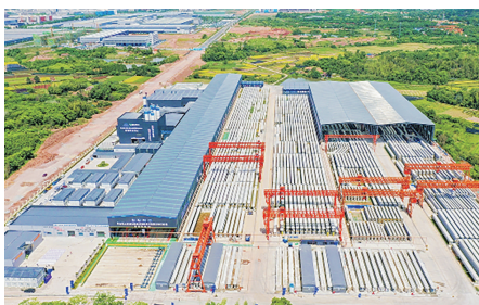
梁板预制现场。许瀚文/供图
