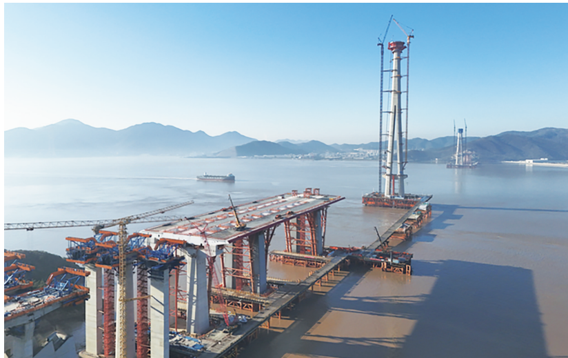
西堠门公铁两用大桥5号主塔建设现场。赵荣发/供图
