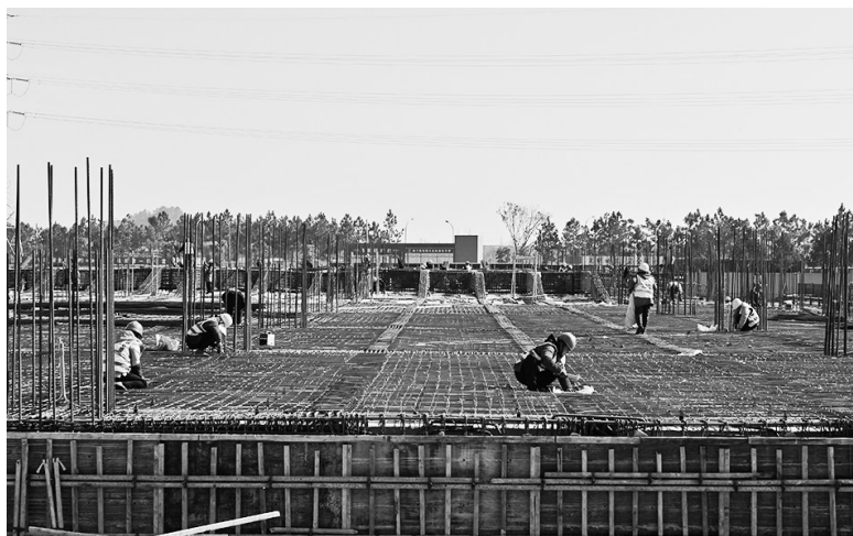
建设现场。蔡紫慧/供图
