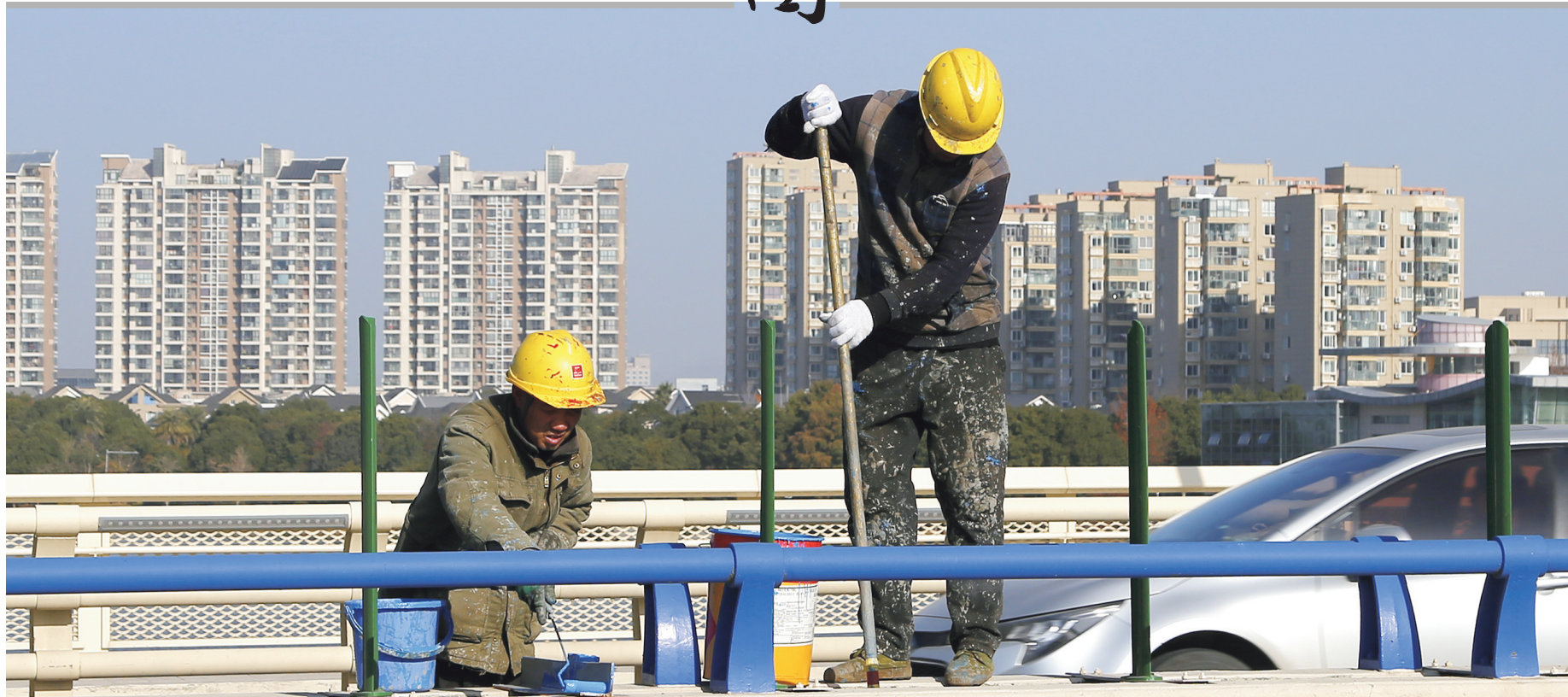
玉环 刷漆 1月11日,在玉环市漩门湾大桥中间隔离带上,工人们正在修复钢质隔离带的表面油漆。 □吴达夫
