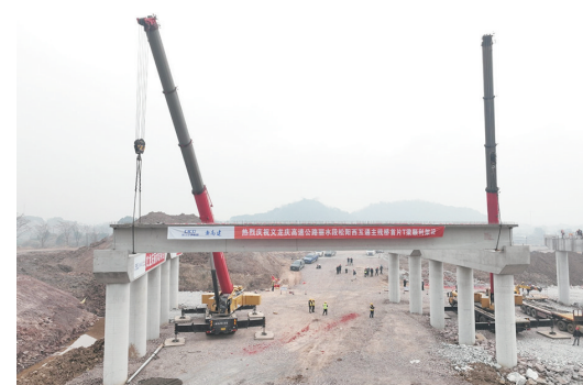
梁板架设现场。孙丽娟/供图
